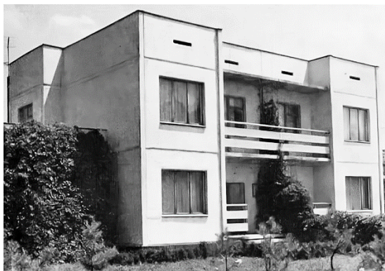
Рисунок 1 – Объемно-блочное строительство в СССР
