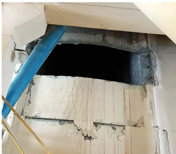
Рисунок 1 – Повреждение стенок силосных блоков
