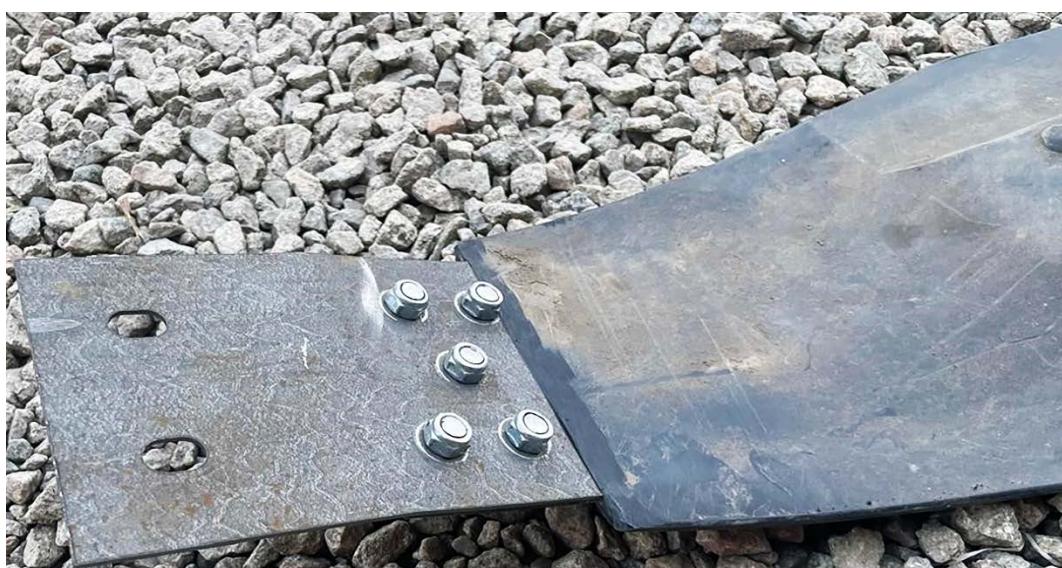
Рисунок 4 – Направляющая с установленной переходной пластиной
