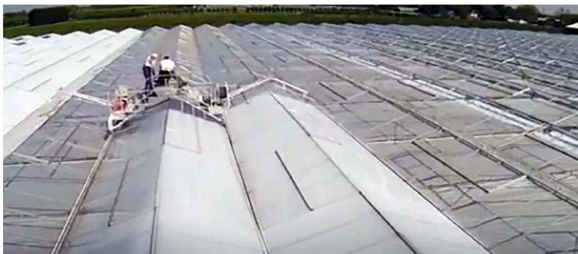
Рисунок 1 – Процесс забеливания кровли теплиц
