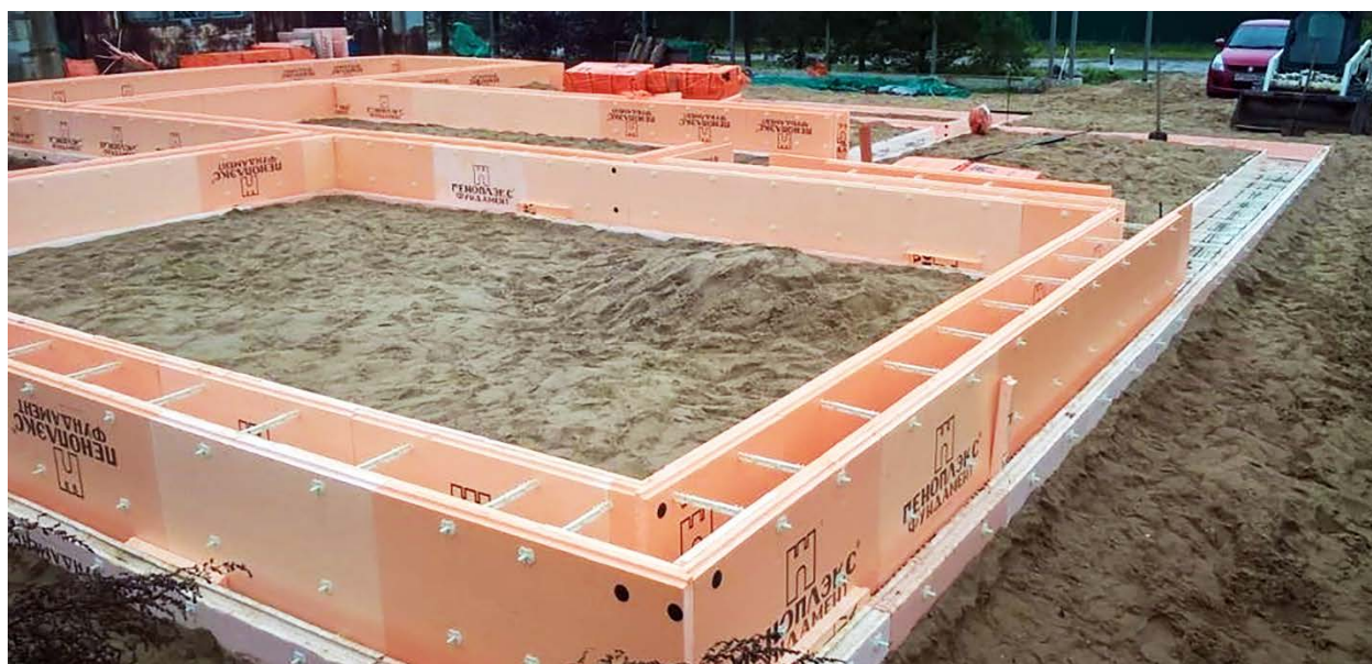
Рисунок 2 – Сборка несъемной опалубки
