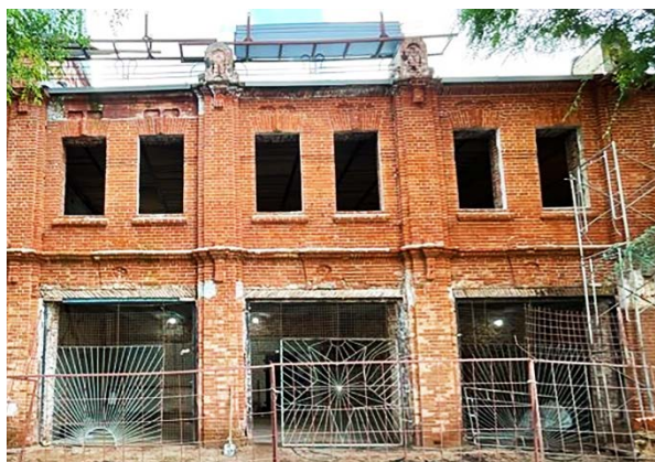
Рисунок 2 – Фасад без штукатурки
