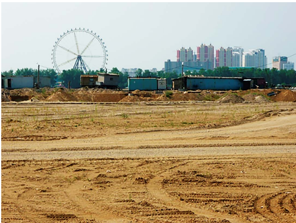
Рисунок 2 – Подготовка площадки строительства на намывной территории реки Амур в городе Благовещенске
