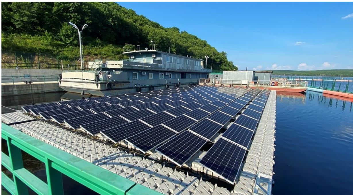
**Рисунок 2 – Плавающая солнечная установка на площадке Нижне-Бурейской ГЭС**
