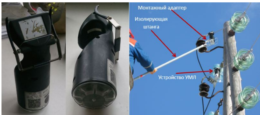
Рисунок 1 – Внешний вид и метод установки устройства мониторинга параметров воздушной линии.
