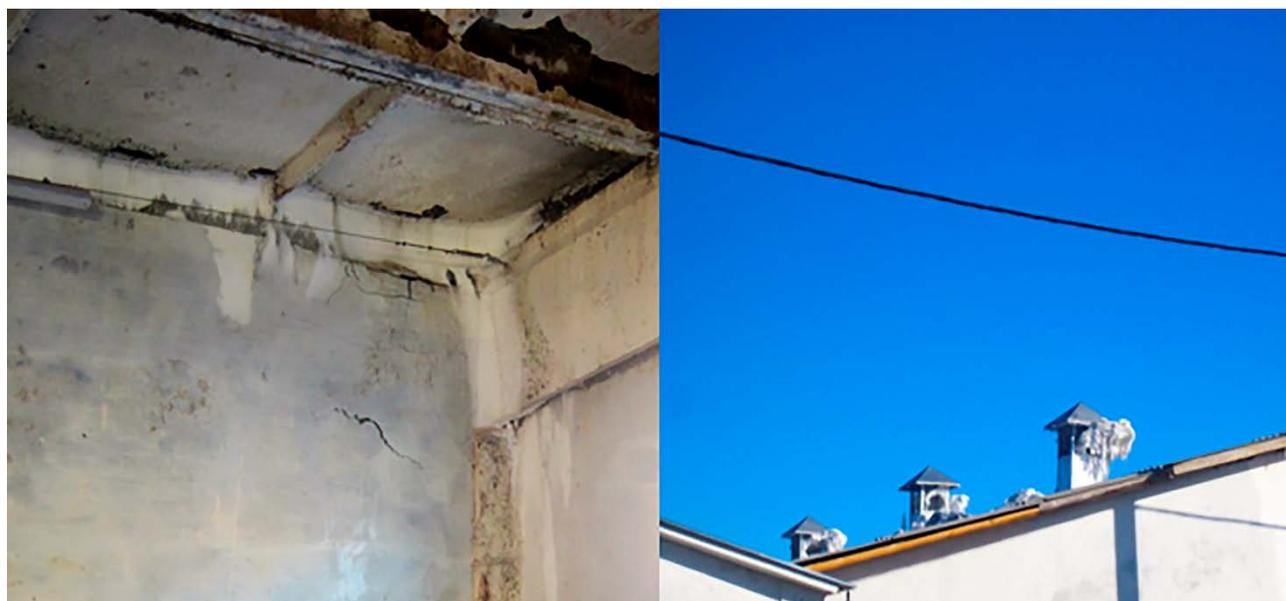
а) иней на ограждающих конструкциях    б) намерзание льда на вытяжных шахтах
