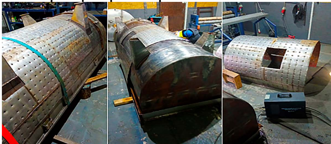
Рисунок 4 – Изготовление панельного теплообменника при ремонте ванны длительной пастеризации
