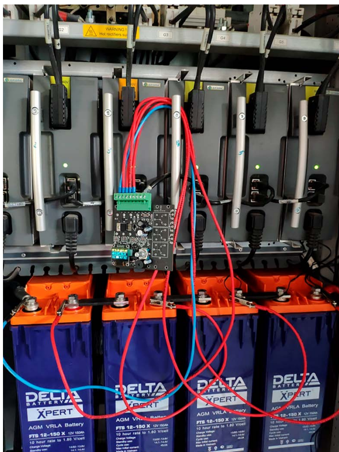
Рисунок 4 – Общий вид пассивного балансира и многоэлементного свинцово-кислотного накопителя
