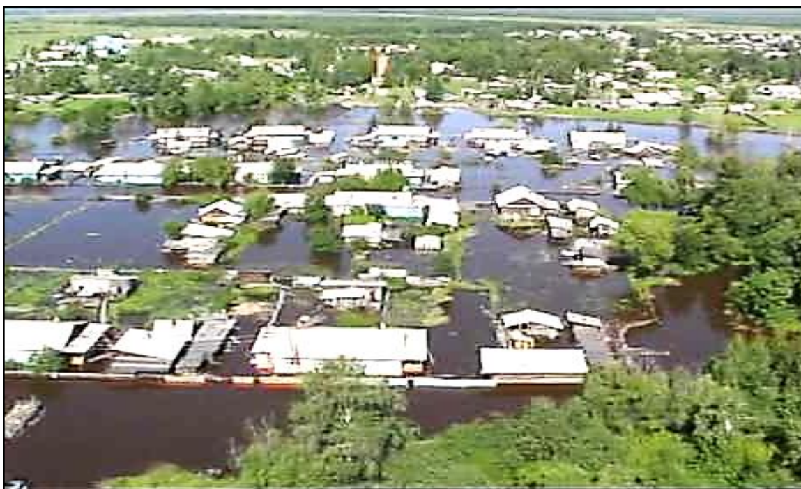
Рис. 2. Затопление жилого поселка
