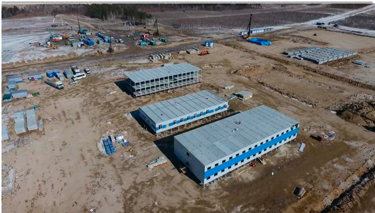
Рисунок – Сборка блочно-модульных зданий на Амурском газоперерабатывающем заводе
