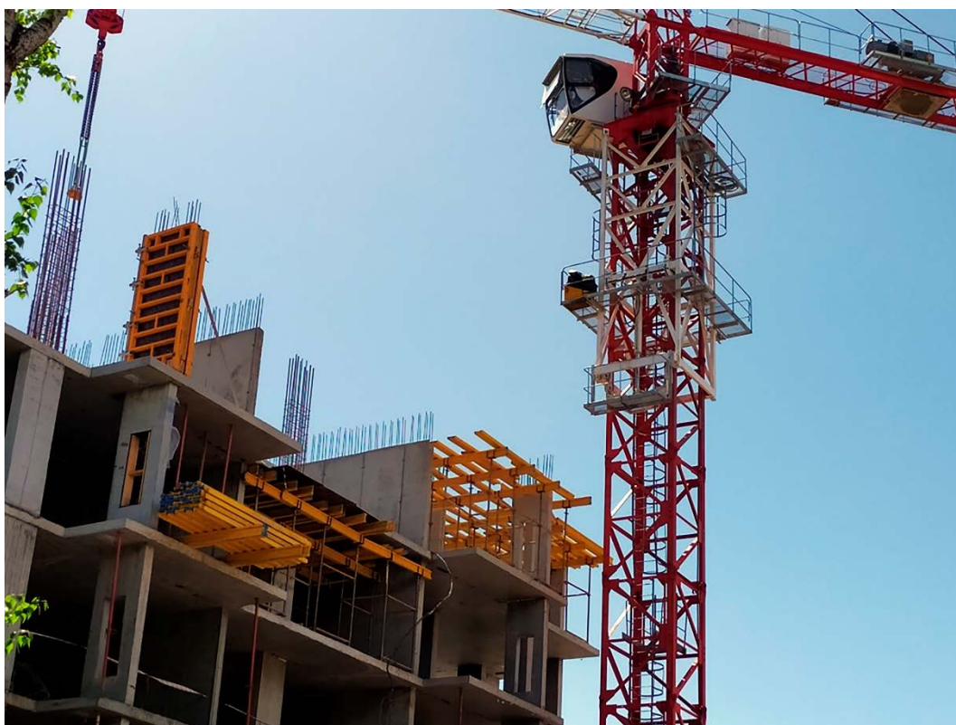
Рисунок 1 – Применение съёмной опалубки на объектах г. Благовещенска
