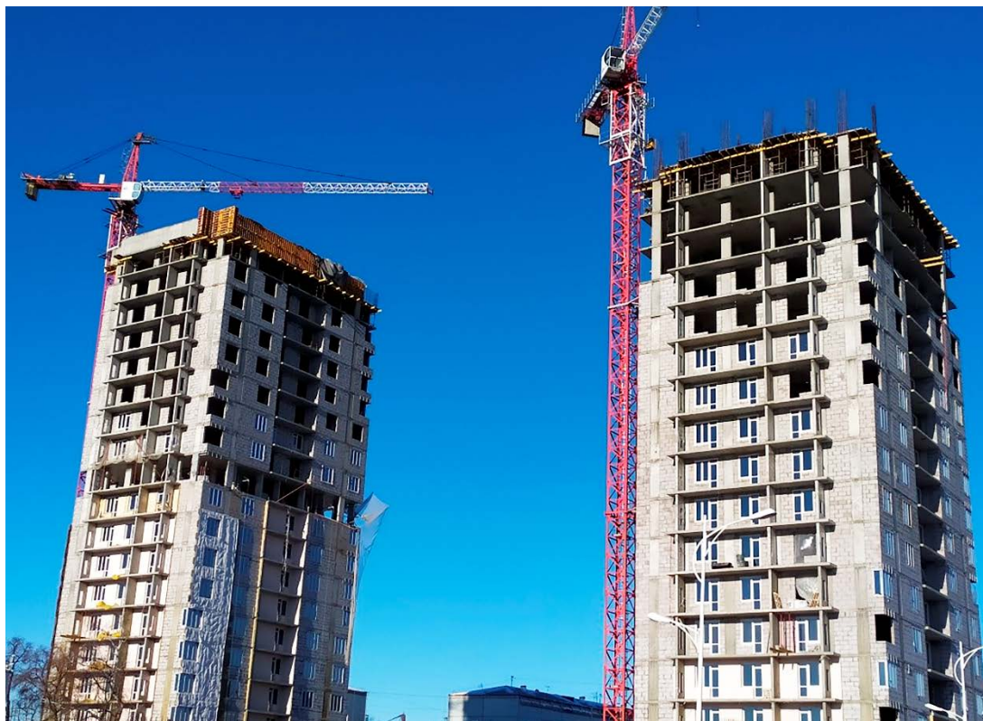
Рисунок 3 – Строительство жилого комплекса в 232 квартале г. Благовещенска
