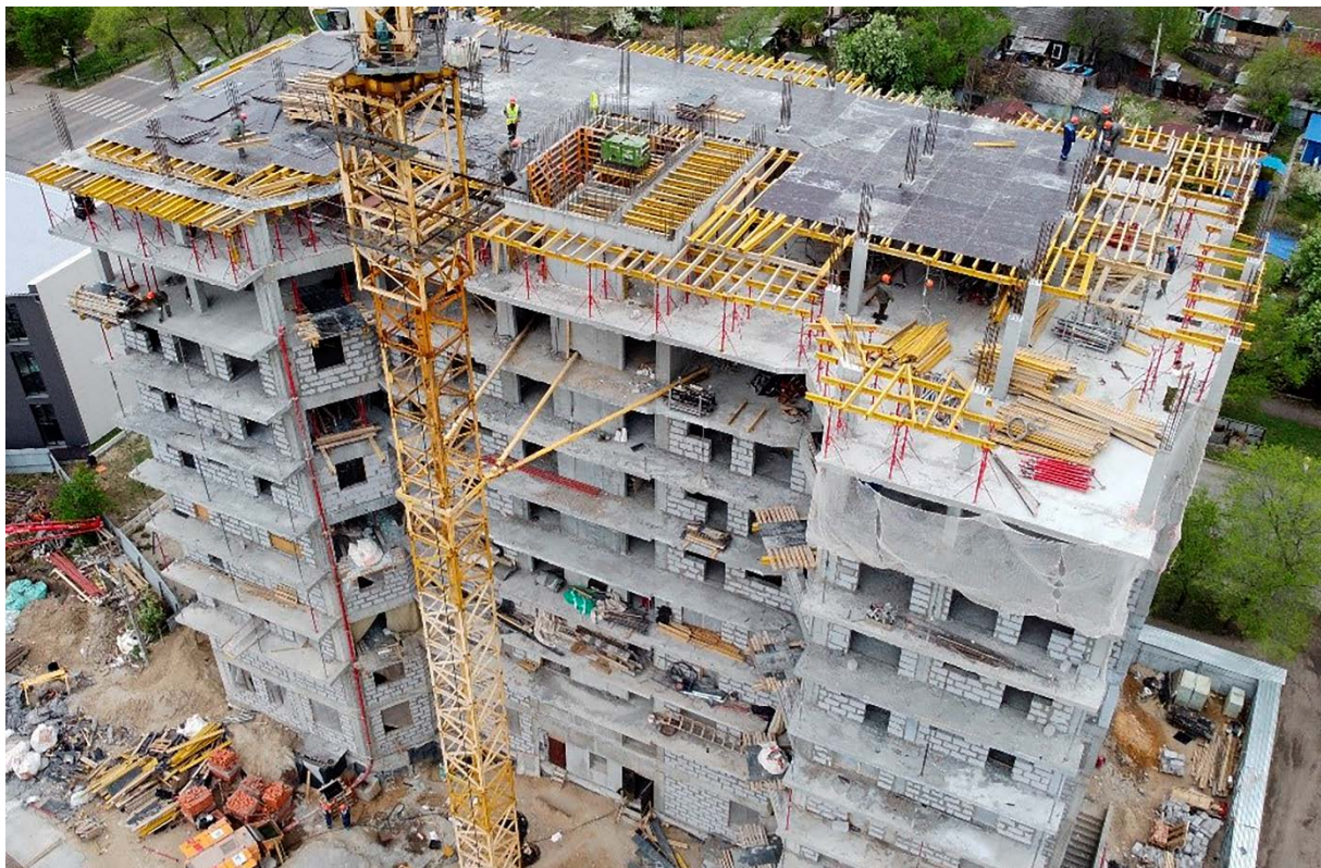
Рисунок 2 – Строительство монолитно-кирпичного жилого дома в 17 квартале г. Благовещенска (жилой комплекс «По улице Мухина»)
